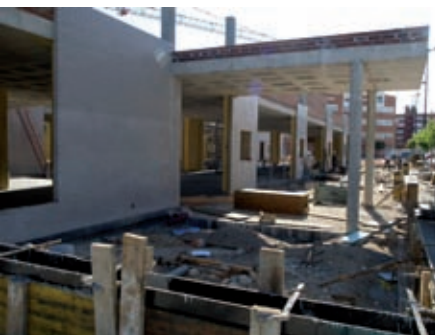
Obras de construcción de la tercera Escuela Municipal Infantil
